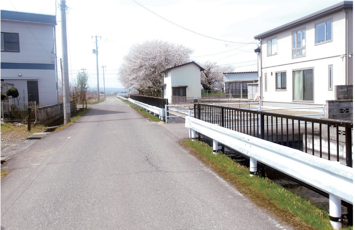
本郷地区(駅前)転落防止柵設置工事
